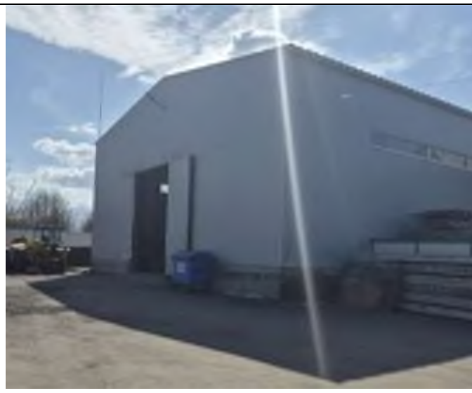
Рис.№№1.9-1.12 Загальний вигляд місць зберігання відходів на території ТЗОВ «ЕКОВЕЙ ВЕЙСТ МЕНЕДЖМЕНТ».
